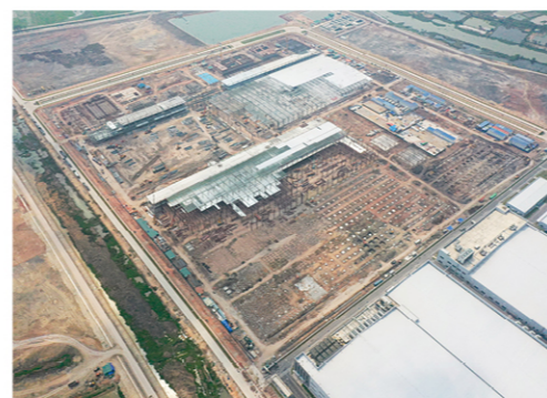
越南晶科太阳能光伏工艺项目
