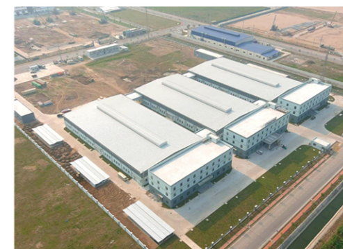
越南河南金箭科技营造一期项目
