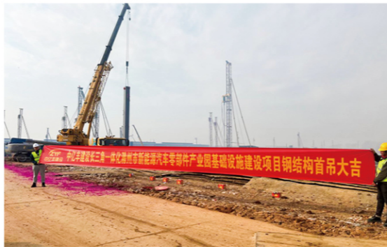
长三角一体化滁州市新能源汽车零部件产业园基础设施建设项目首吊大吉
